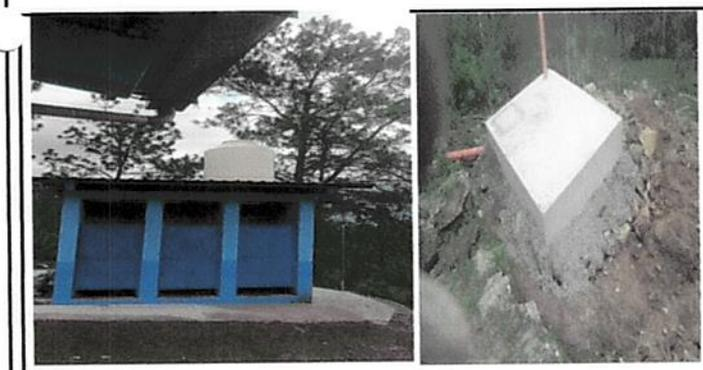
Foto 5: Reparación y sustitución de letrinas por baños y perforación de fosa reforzada.
