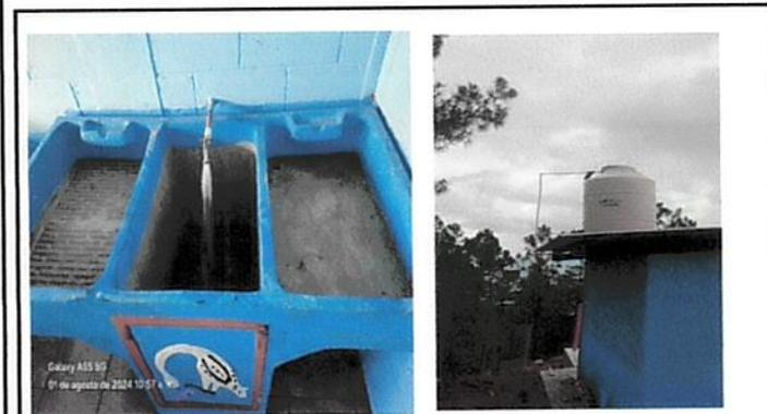
Foto 3: Instalación de Pila y tubería de agua de tinaco.
