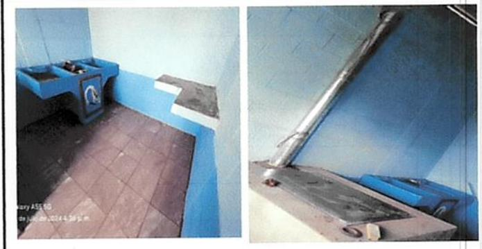
Foto 2: Sustitución de estufa y chimenea, pintura de cocina, sustitución e instalación de piso cerámico
